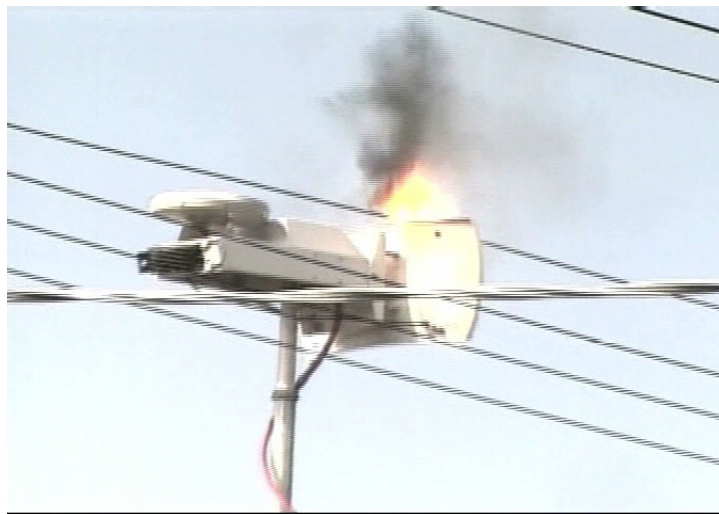
Photo of Actual Wire Strike Explosion
